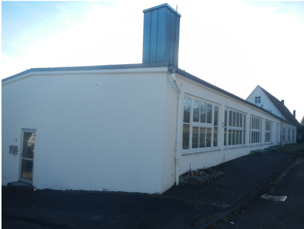
Foto 3: Blick von Osten auf die Gewerbehalle. Im Bildhintergrund das Wohnhaus.
