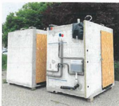
Zwei der sogenannten Fertignasszellen, die per Kran in die Bewohnerzimmer transportiert werden.
