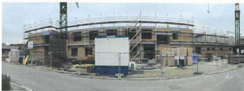
Der aktuelle Baustand des Seniorenzentrums am 25. Mai 2023.
